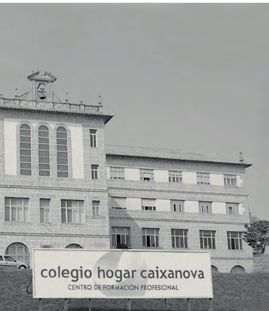
Este es el edificio del colegio; dónde estaba instalado todo el material y dónde se trabaja para la investigación y tratamiento del estrabismo
